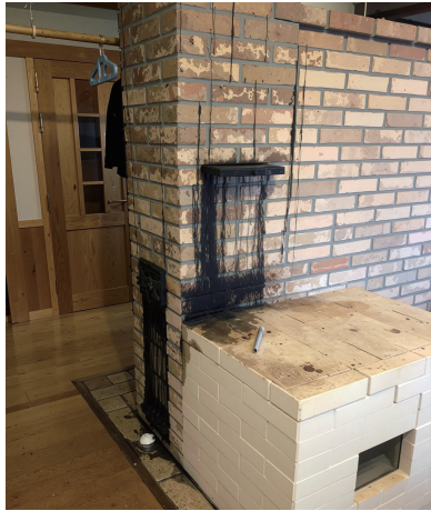
本体・煙突の目地や金物の隙間からタールが垂れ出している
